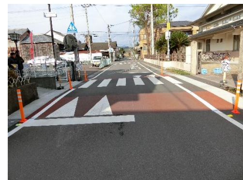
追加設置した スムーズ横断歩道
