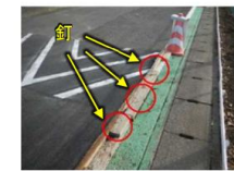
図参 6-2 既設の縁石やブロック塀等に接せずハンプを設ける場合の横断端部処理例
