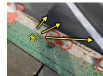
図参 6-2 既設の縁石やブロック塀等に接せずハンプを設ける場合の横断端部処理例
