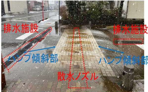
消雪パイプを設置したハンプ
