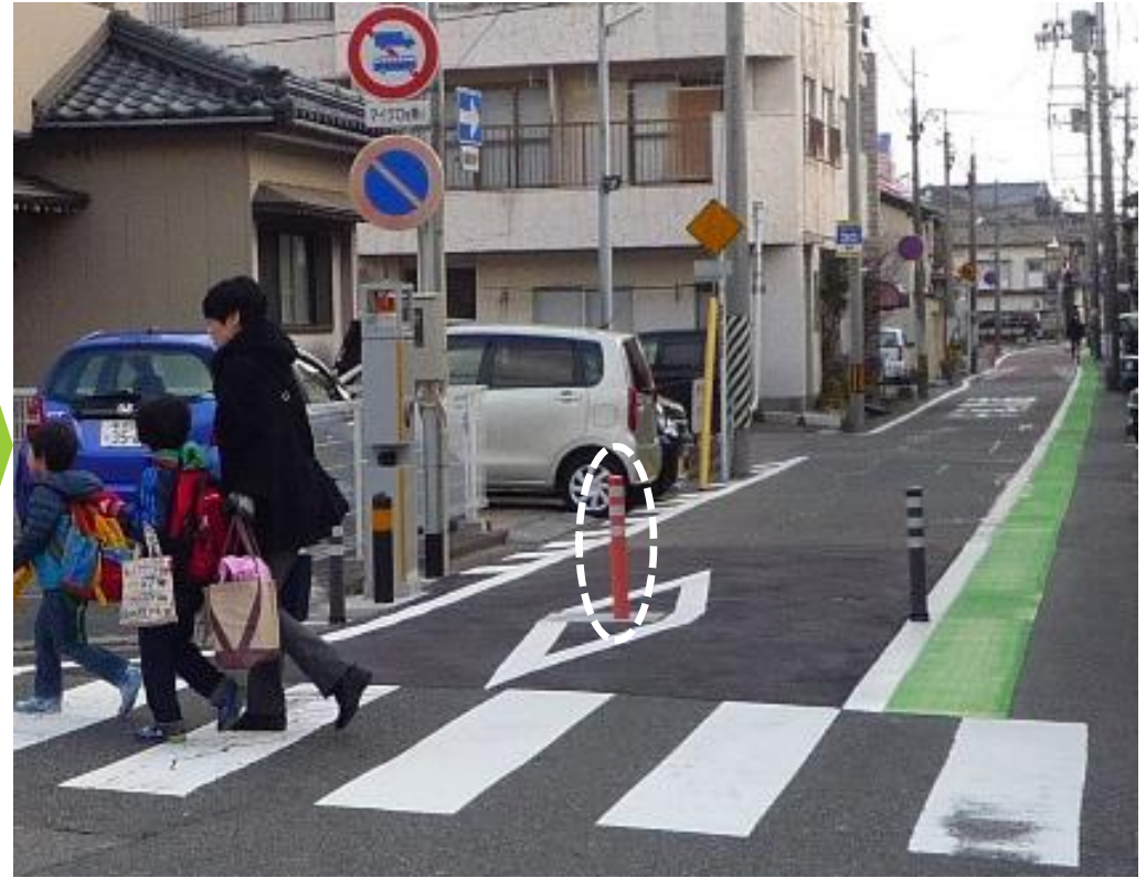
〔ボラードが上昇した状態〕
