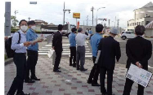
道路の現地診断の実施状況(愛知県安推連)
