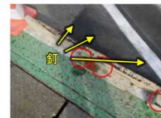
図参 6-2 既設の緑石やブロック塀等に接せずハンプを設ける場合の横断端部処理例
