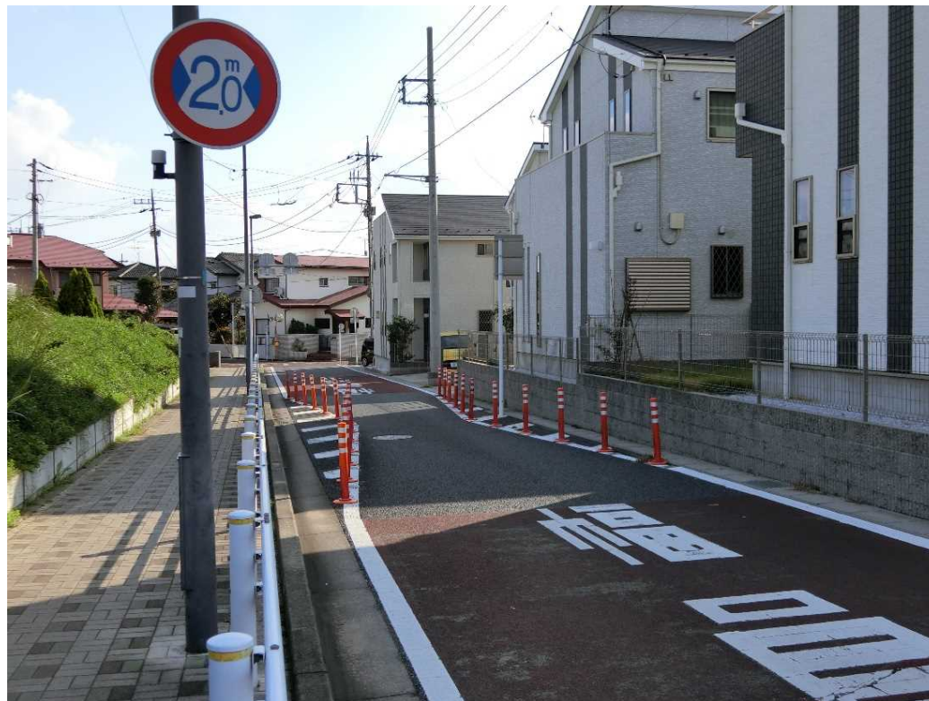
車両の幅を限定した狭窄部の事例
