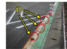
図参 6-2 既設の緑石やブロック塀等に接せずハンプを設ける場合の横断端部処理例
