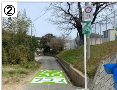
ゾーン30プラス看板・路面表示
