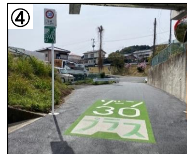
ゾーン30プラス看板・路面表示
