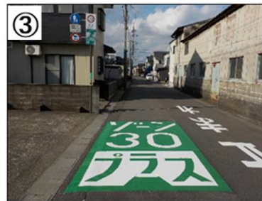
ゾーン30プラス看板・路面表示
