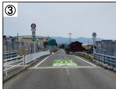
ゾーン30プラス看板・路面表示
