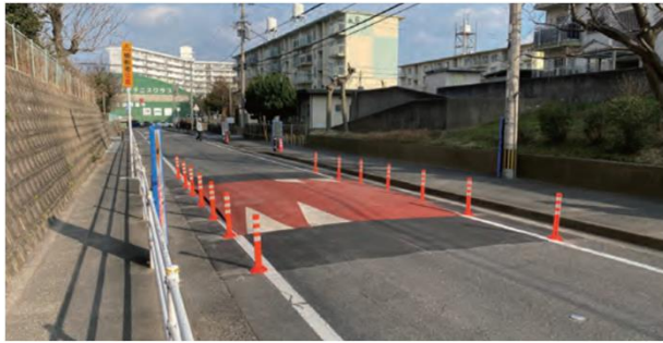
ハンプの試験設置の様子
