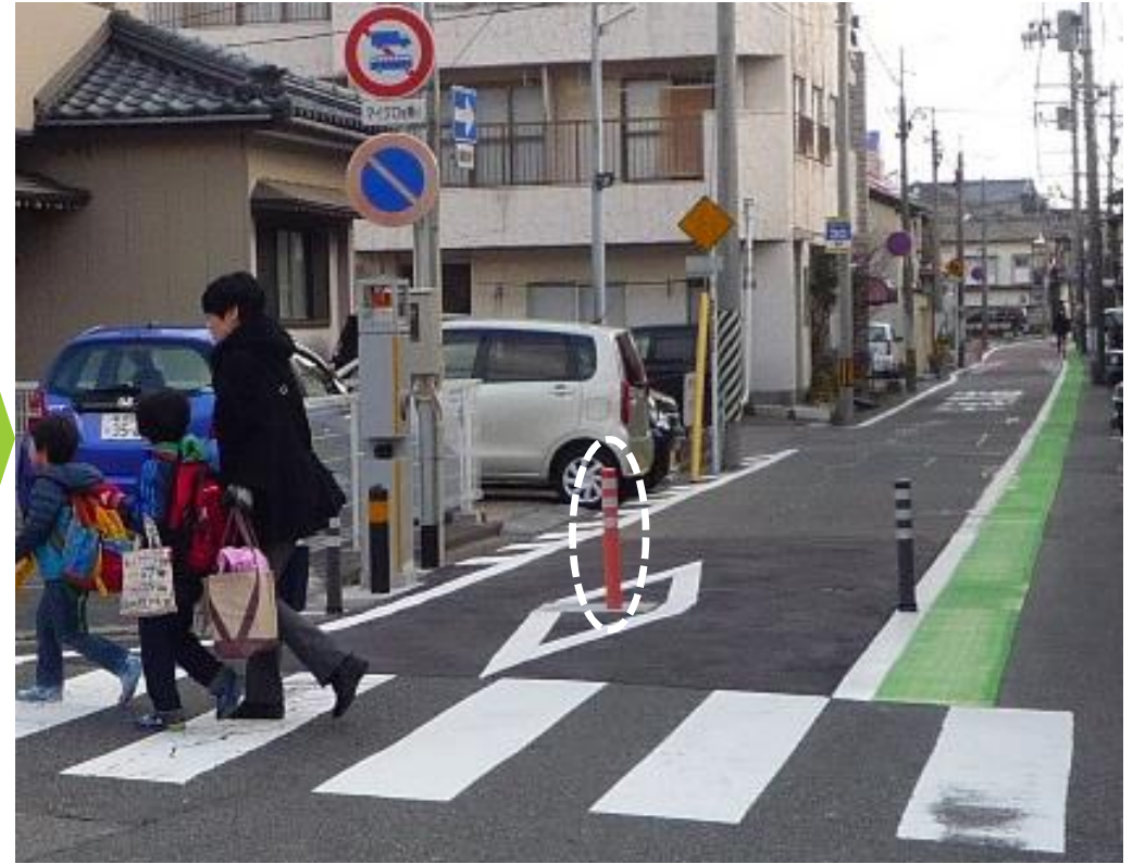
〔ボラードが上昇した状態〕
