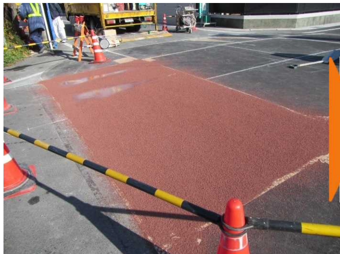
薄層カラー舗装
