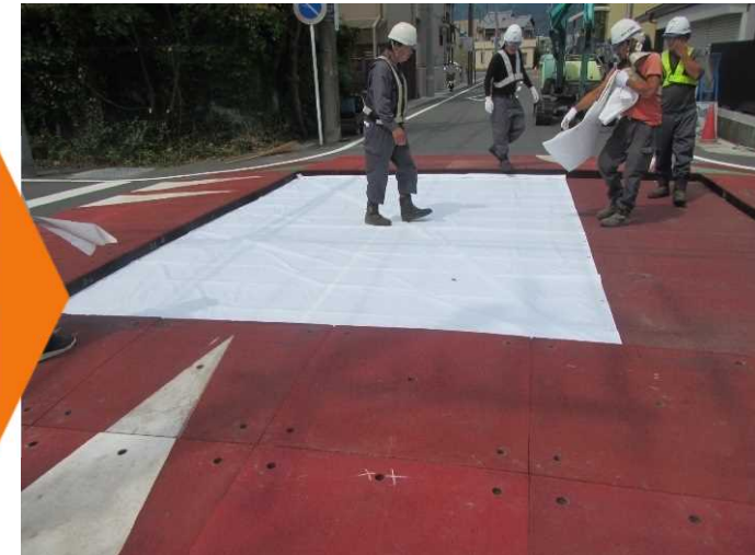
養生シート設置
