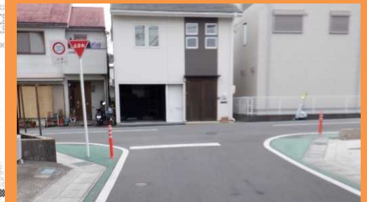
交差点狭さくの強化 (ポストコーンの設置)
