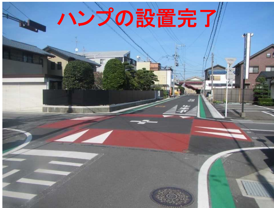
ハンプの恒久設置
