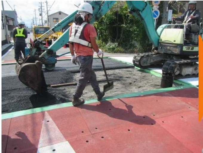
平坦部の舗装
