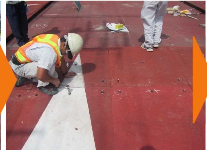
アンカー設置
