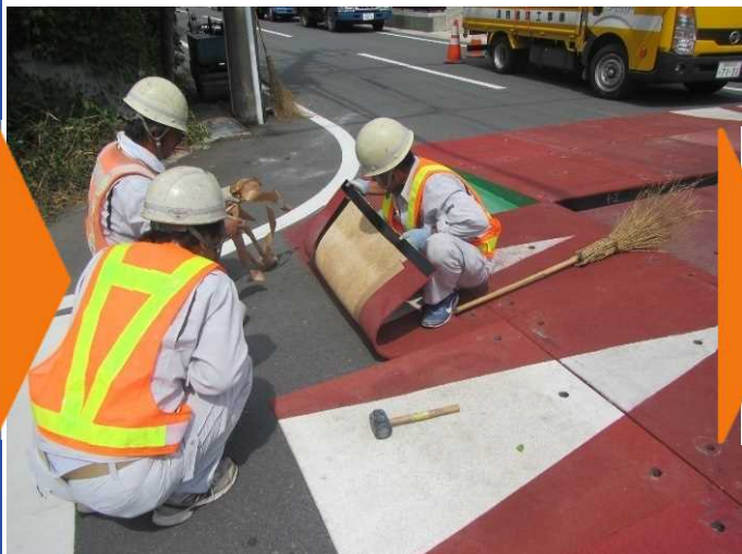
接着テープ貼付け
