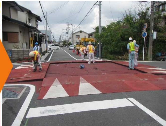
仮設ハンプ設置状況
