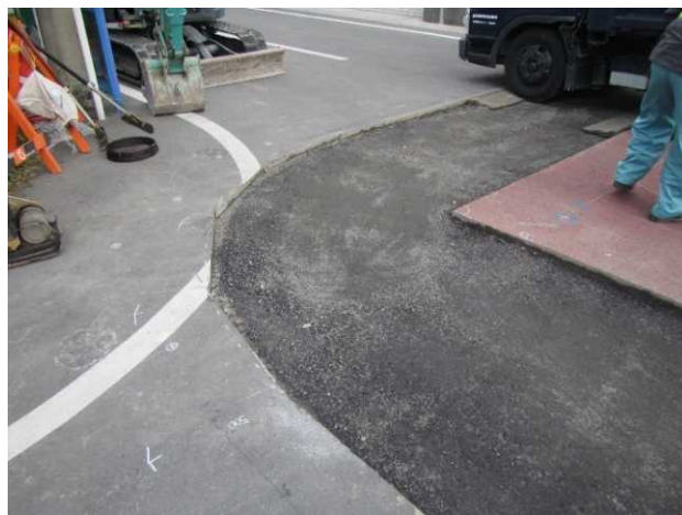
舗装版取壊し
