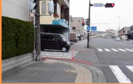
交差点狭さくの強化 (ポストコーンの設置)
