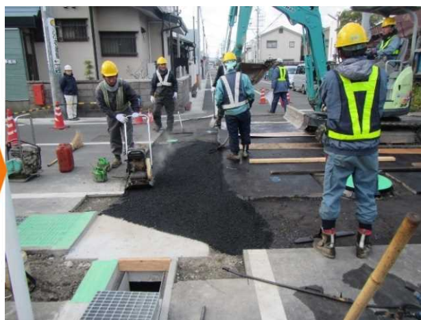
サイン曲線部基層
