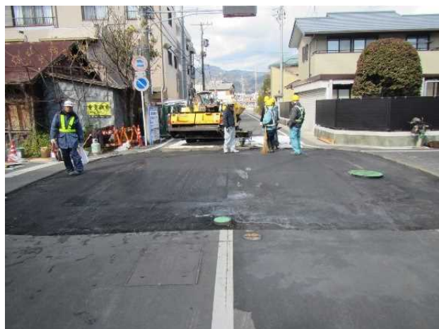
ハンプ内基層完成
