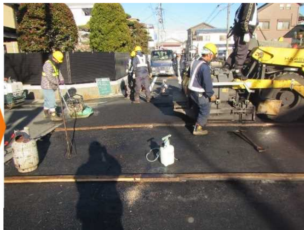
傾斜部・平坦部表層部①
