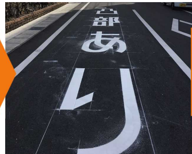
区画線・道路附属施設
