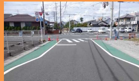
交差点狭さくの強化 (ポストコーンの設置)
