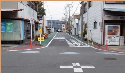
交差点狭さくの強化 (ポストコーンの設置)
